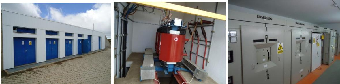
Estación transformadora, uno de los transformadores y sala de control
